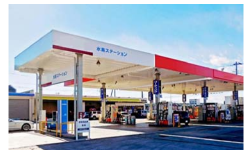
【水素ステーション】
